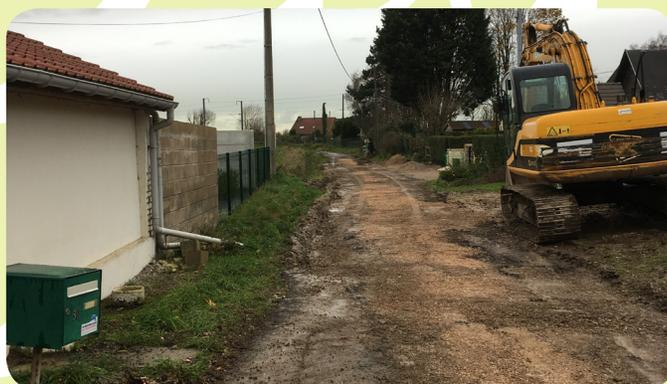
Les travaux d'extension du réseau d'assainissement des eaux usées, rue du Mont Hulin ont été réalisés en décembre et vont permettre le raccordement de 15 logements.
